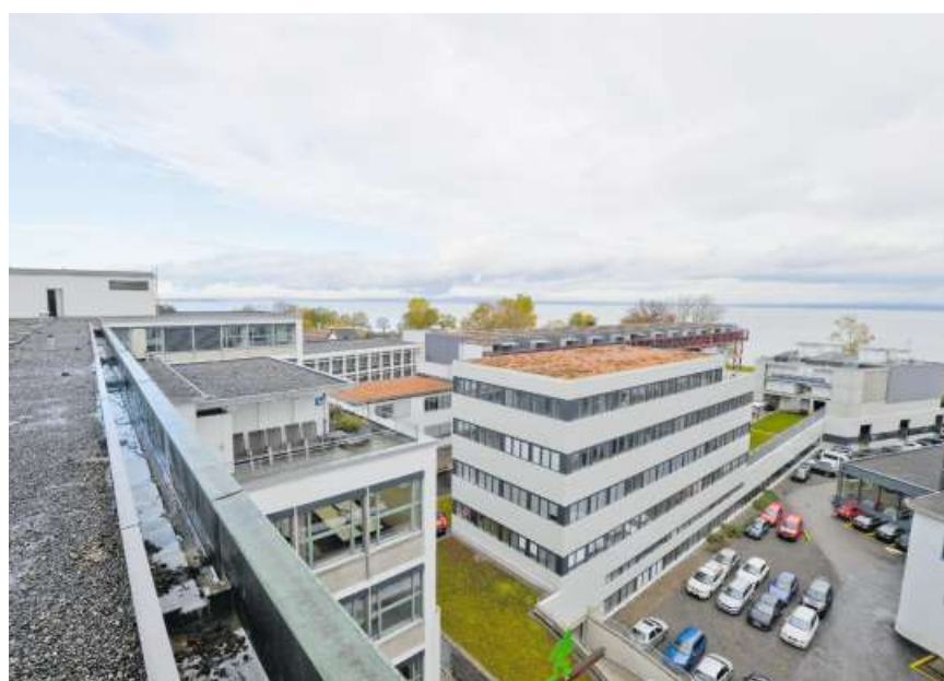
Bürohaus (Mitte) und Seehaus beim See wurden dieses Jahr fertiggestellt.
